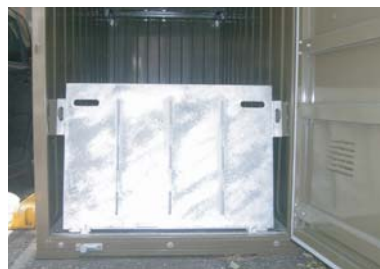
収納時のスロープ(幅1030×奥700mm)
